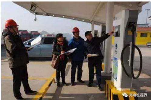
“快充站全部采用直流充电，相比较太原市内的交流充电桩，直流充电速度更快，能在较短时间内将电池充满。而且，当电池即将达到容量饱和的时候，直流充电会自动降低电流强度，对电池起到保护作用。”山西省电力公司负责项目验收的李岩介绍，“太原市高架桥下的充电桩只对比亚迪汽车专用，而我们在高速服务区建设的充电桩则采用国家统一标准，可以服务包括比亚迪在内的绝大部分电动汽车品牌，驾驶员可在服务区休息或用餐时进行充电，既方便又简单。”
